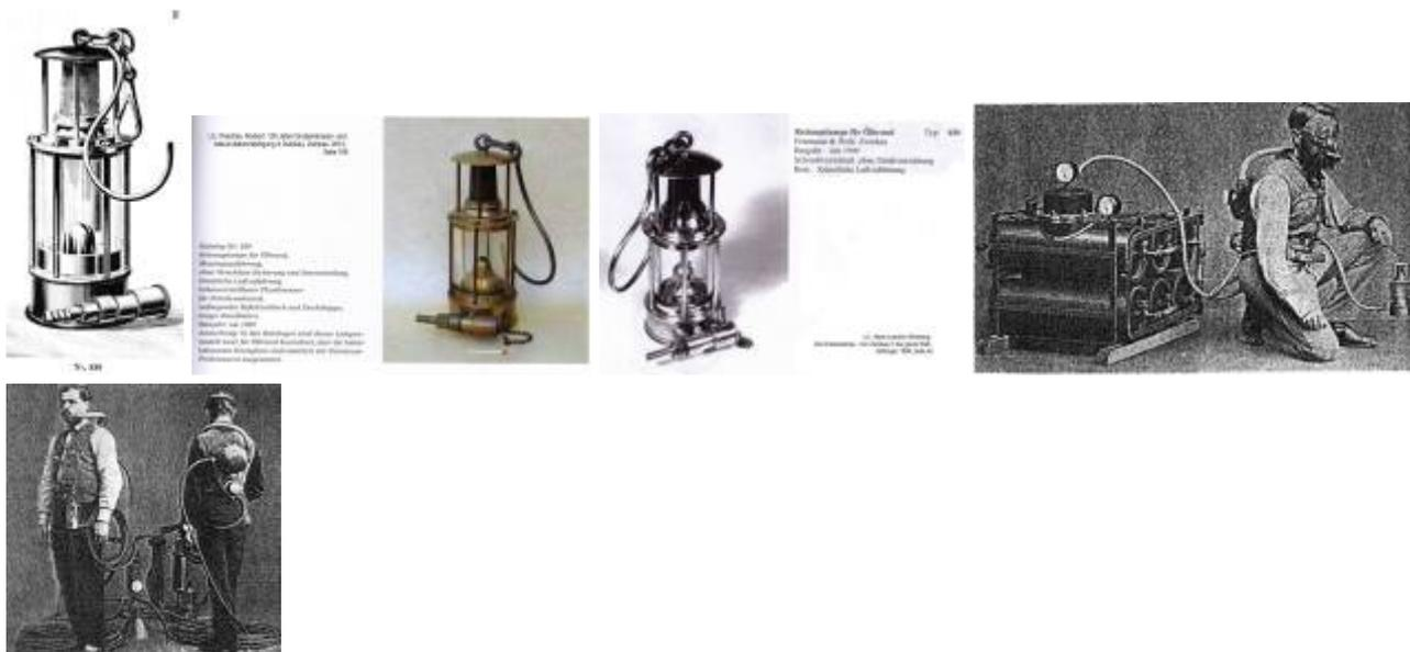
Um nach Explosionsunglücken an den Unfallort zu gelangen und u.a. weitere Explosionen zu vermeiden wurde z.B. aus Ledersäcken Luft für den Retter und die Grubenlampe mitgeführt (System Galibert). Anfänglich Luftpumpen, später auch Hochdruckgeräte versorten Retter und Geleucht mit Frischluft. Bei diesem Lampenmodell von Friemann&Wolf ist der Lampentopf von einem zweiten Behälter umgeben. An diesem ist der Schlauchstutzen montiert für die Aufnahme des Druckschlauches für die Frischluft.
