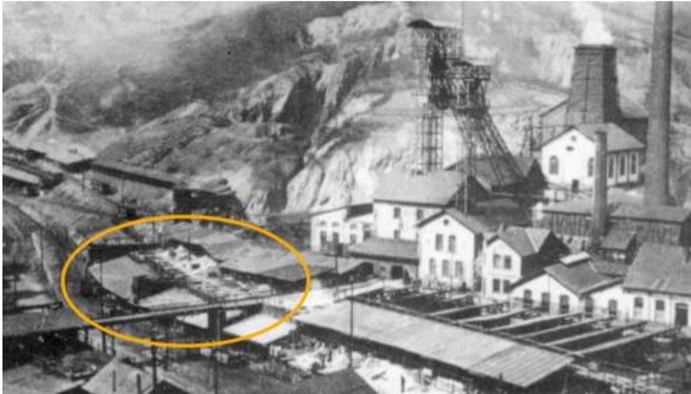
In der Ellipse ist die Lage der Röstofen-Batterie zu erkennen. Im Hintergrund sehen Sie unbewaltete (kahle) Berghänge. Durch das Rösten wurde zum Beispiel Schwefel freigesetzt. Schwefeldioxid ist ein giftiges Gas welches in Verbindung mit Wasser eine leicht schweflige Säure bildet. Das dann in der Umgebung von Röstöfen (bei Hüttenwerken, Hochöfen)
